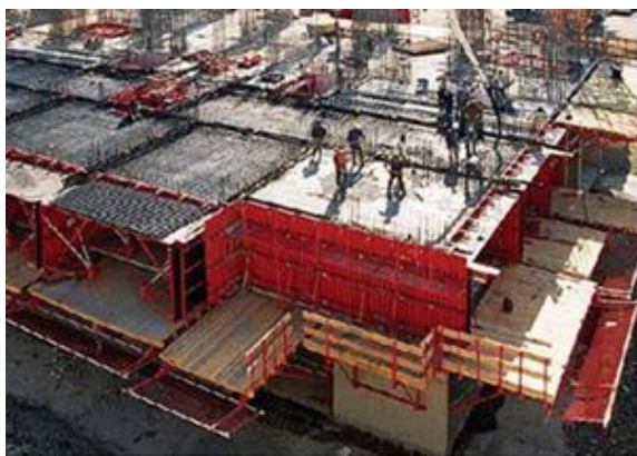
Рис. 5. Возведение многоэтажных зданий с использованием объемно-переставной опалубки
