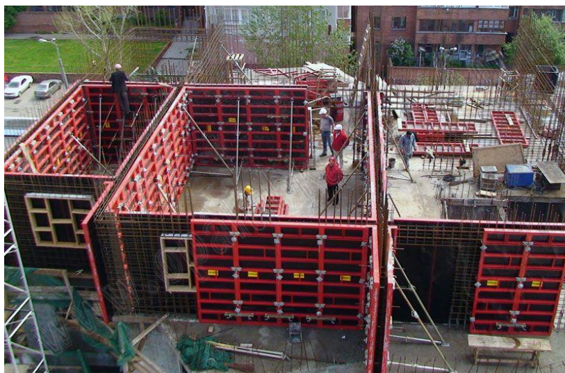
Рис. 4. Возведение многоэтажного здания с использованием крупнощитовой опалубка стен
