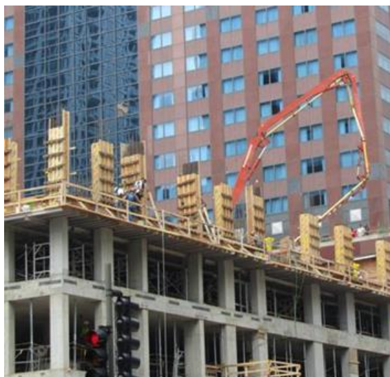
Рис. 3. Подача бетонной смеси на захватку с использованием распределительной стрелы
